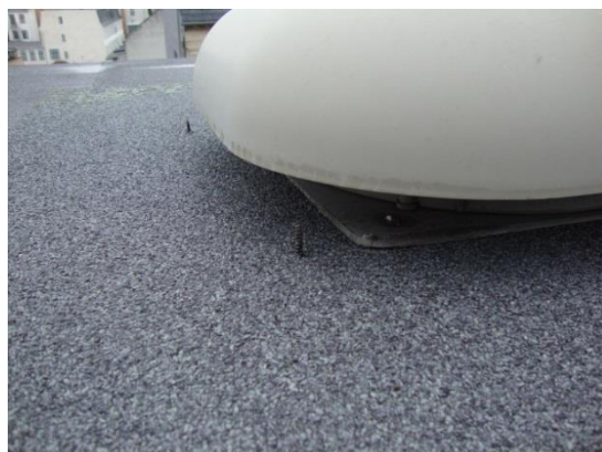
Fra TDC's teknikrum var der skruet skruer hele vejen op gennem tagappen.
