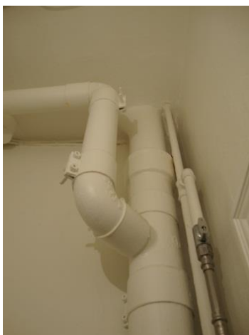
Faldstamme i lejlighed. Foretaget partielle Faldstammeudskiftninger i foreningen.
