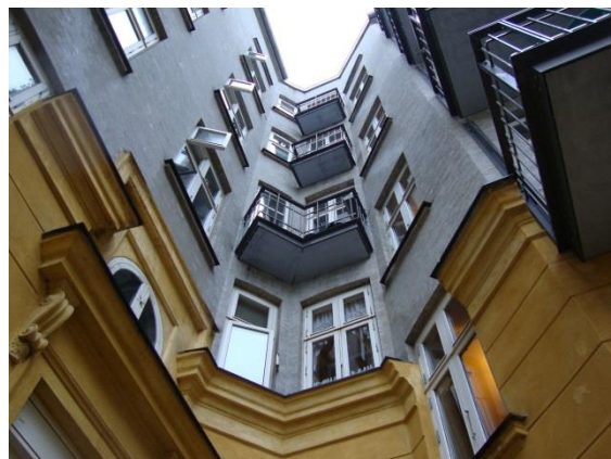
Gårdfacade udført med pudset og malet underfacade med refendfuger samt pudset og malet overfacade.
