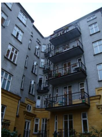
Gårdfacader har fået eftermonteret altaner i 2008.
