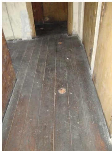
Etageadskillelse mellem boliger og loft var efterisoleret ved indblæsning af granulat.
