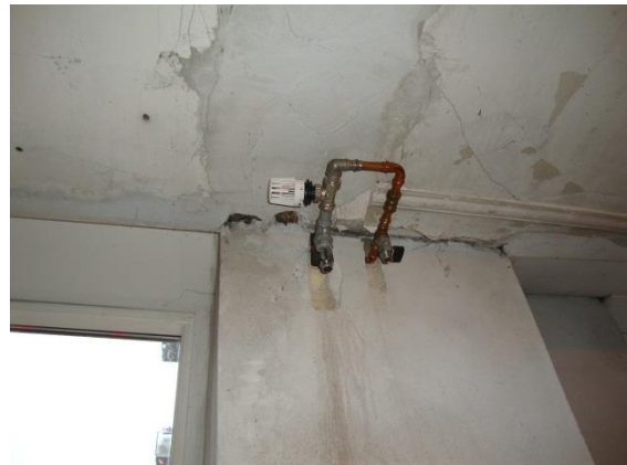
I cykelkælder ses termostat samt aftapningshaner.
