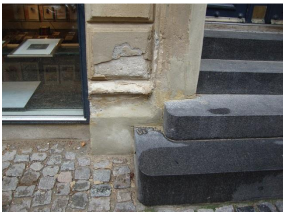
Mindre afskalling omkring hovedtrappe.
