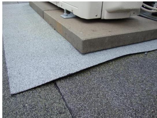
Hvor TDC's antenne er fastgjort er tagpap udlagt løst på eksisterende, og sat i spænd.
