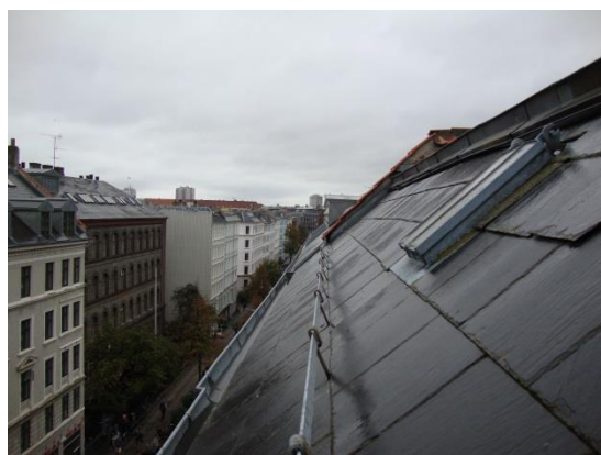
Skråflader er udført med snestopperjern.
