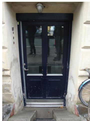
Kælderdoor mod Charlotte Ammundsens Plads.
