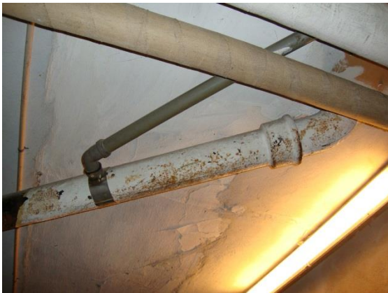
Faldstammer i kælder var af ældre dato.
