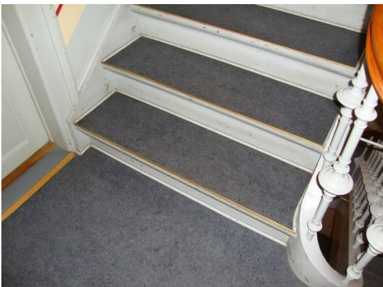
Hovedtrapper udført med linoleumsbelægning og malet træværk.
