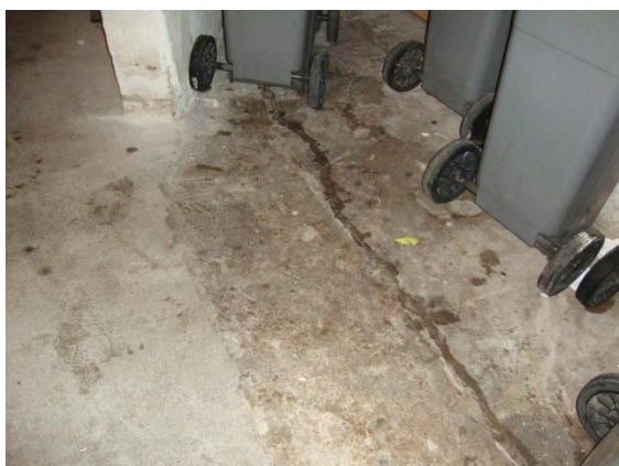
Gulv i kælder fremstår som et støbt betongulv.
